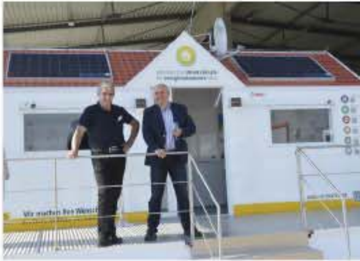
Das Schau-Haus kombiniert Infra- rotheizung und Photovoltaik.
